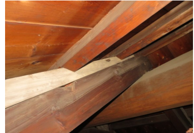
店蔵2階内部。屋根の角度も時代により変化、屋根の垂木も、屋根の角度により足されていた
